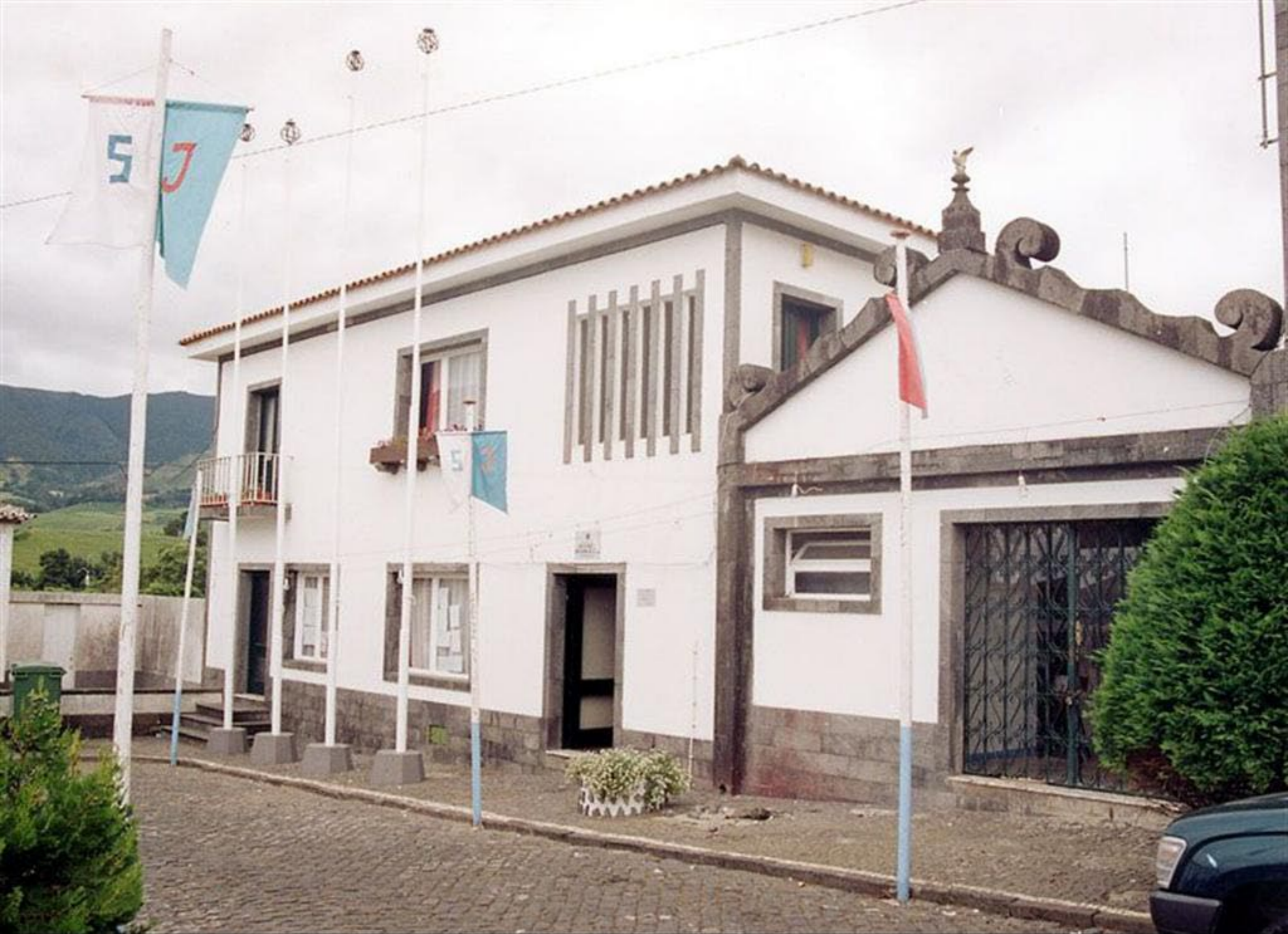
Sede da Junta de Freguesia
